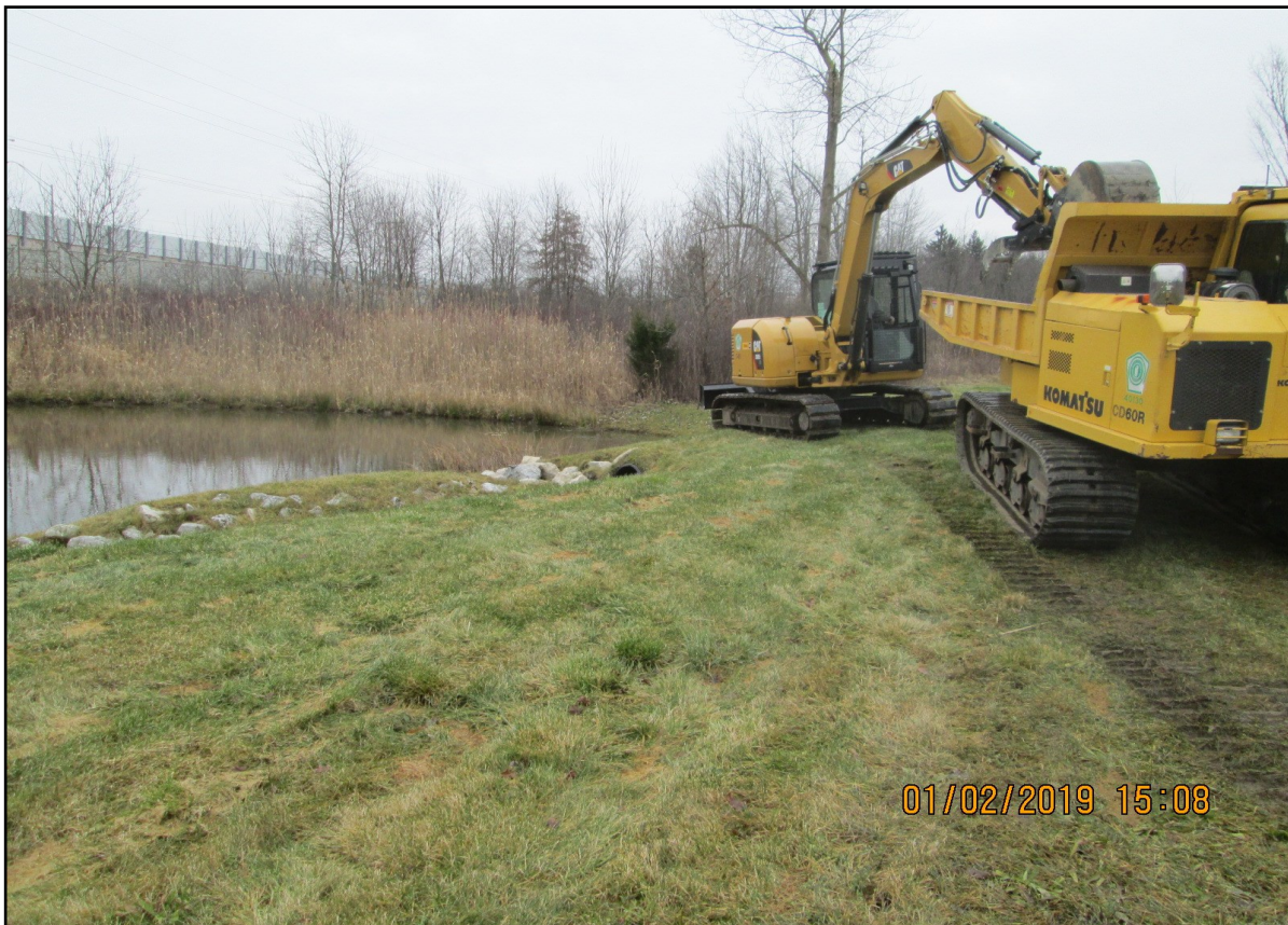
Skyhaven Subdivision Drainage Maintenance
